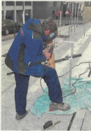
Abgerundet wurden die zuvor spitzen Kanten am Handlauf. FOTO: KETTERL
