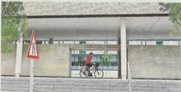
Anlass zum Ärger: der Lärmschutz beim Hilda-Gymnasium.
