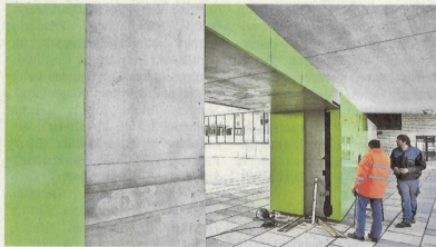
Jetzt gilt's: Die Vertäfelung der Hilda-Wand wird fertiggestellt. Auch ein dann fehlerfreier Schriftzug soll die Mauer noch im Verlauf dieser Woche zieren. FOTO: SEIBEL
