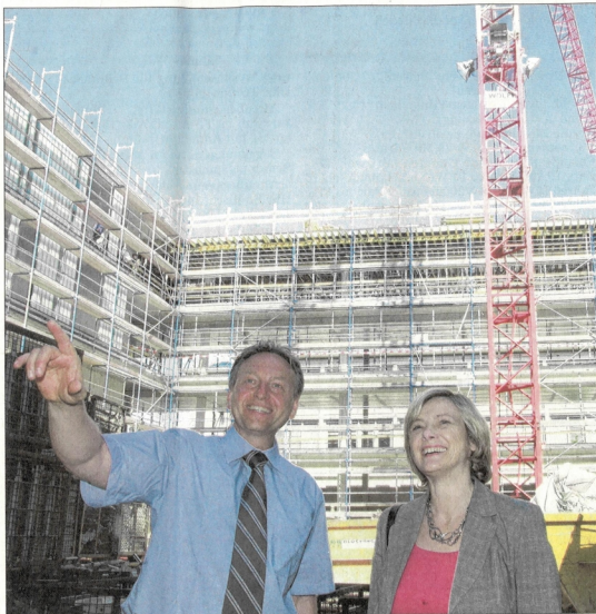
DAS NEUE HILDA-GYMNASIUM nimmt sichtbare Formen an. Über den Abschluss der Rohbauarbeiten freuen sich Bürgermeister Alexander Uhlig und Schulleiterin Edith Drescher. Foto: Wacker
