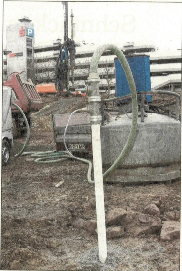
EINE DER BOHRUNGEN, mit denen chlorierte Kohlenwasserstoffe nachgewiesen wurden.
