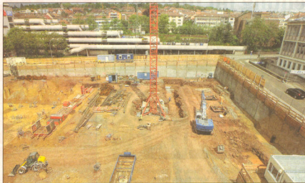
Unterschiedliche Bodenverhältnisse: Auf der Ostseite (rechts) liegt Fels sehr hoch, zur Museumstraße hin befindet sich die Sandsteinformation viel tiefer.
