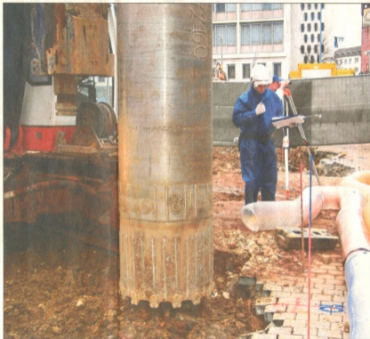
UNTER STRENGEN SICHERHEITSVORKEHRUNGEN haben gestern Nachmittag die Bohrungen auf der Baustelle des Hilda-Gymnasiums begonnen, weil im Boden Altlasten lagern. Foto: Ehmann
