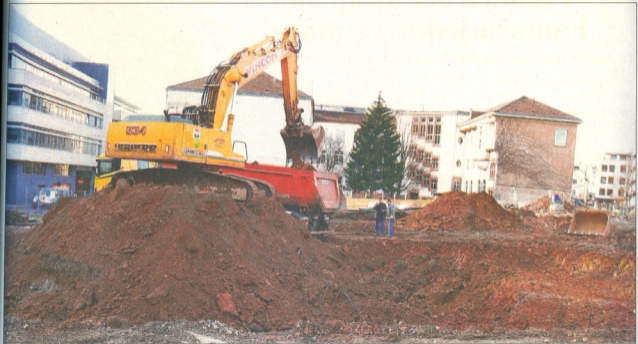
Die Aushubarbeiten für das neue Hilda-Gymnasium haben begonnen. Seit gestern Vormittag sorgen die Bagger für die nötige Basis des Neubaus. Die nächsten Tage werden zügig Lastwagen die Baustelle anfahren und das Erdmaterial abtransportieren. Dies kann unter Umständen zu Beeinträchtigungen des Verkehrs in der Kiehnlestraße führen. Foto: Wacker
