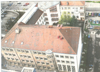
DER NEUBAU DES HILDA-GYMNASIUMS mit einer Großsporthalle für 2 000 Zuschauer ist seit gestern beschlossene Sache. Das Bild zeigt die Schule in ihrem bisherigen Zustand. Foto: Kolros
